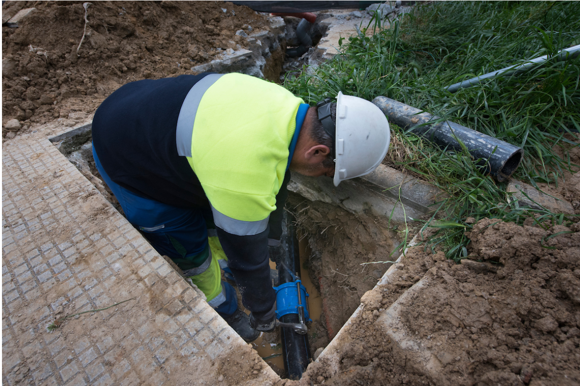
Operario de UTE Gestión Cangas nunha obra a pé de rúa. Punto GA Comunicación | M. Riopa
