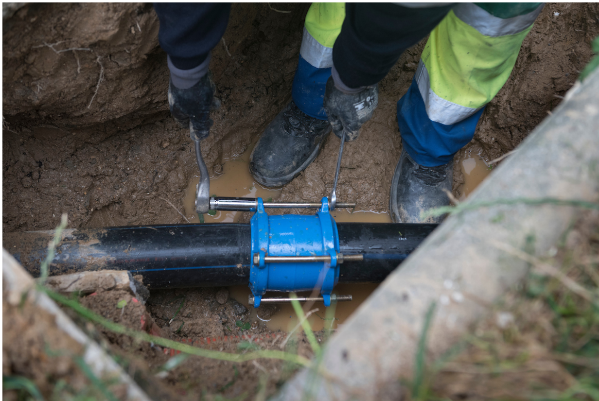
Operario de UTE Gestión Cangas revisando o sistema de saneamento. Punto GA Comunicación | M. Riopa
